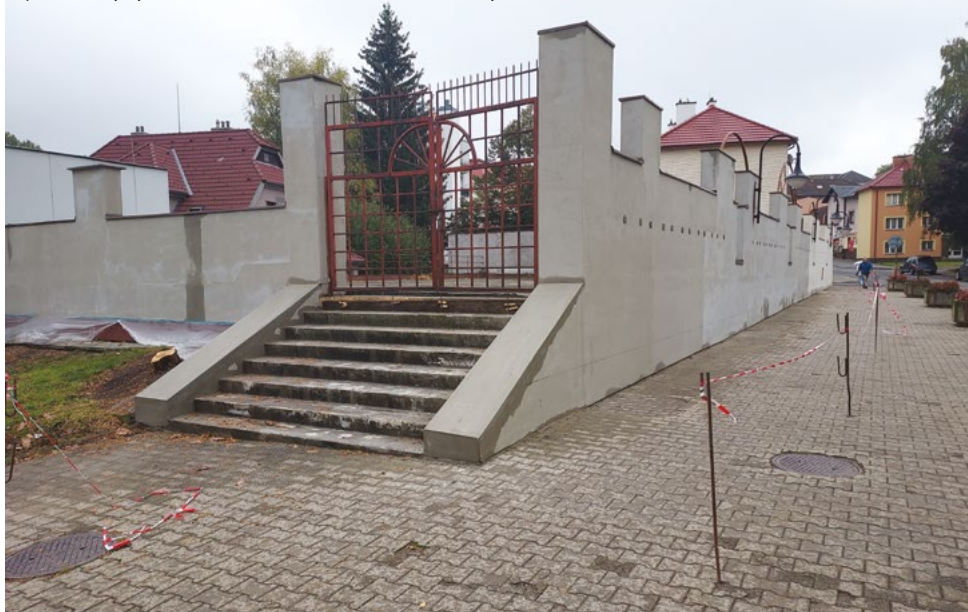
Oprava fasády bývalé tržnice na Novém náměstí / foto: Jiří Holý
